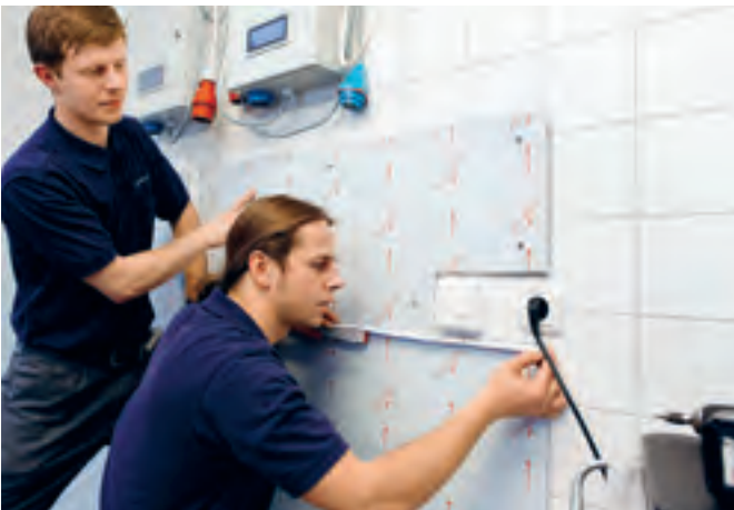
Schutz für die Kacheln im Casino: Die Schlosser Denis Becker (l.) und Angelo Piscopo befestigen Edelstahlbleche an der Wand der Essensausgabe.
